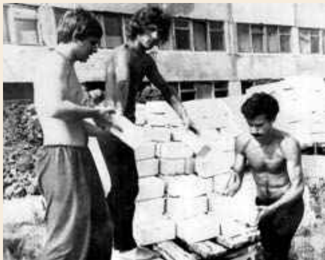
Стройотряд «Ураган» на строительстве комбината питания, 1980 год
