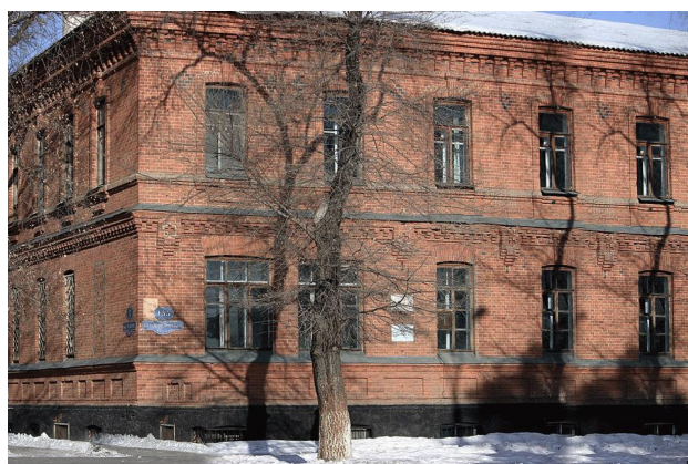
Рис.5. Здание после реставрации
