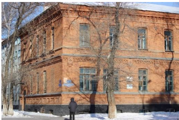
Рис.4. Здание в начальном виде
